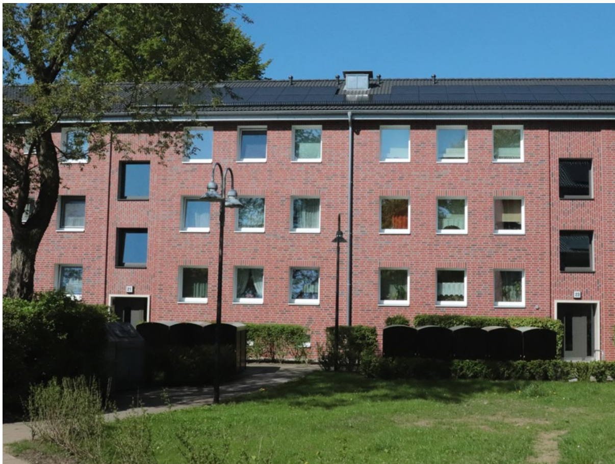
Start der energetischen Sanierung im Quartier Moorgrund: 48 Wohnungen werden modernisiert – Ziel: 60 Prozent weniger Energieverbrauch.
