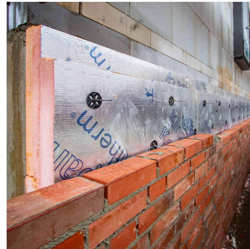
Dämmung einer Fassade
