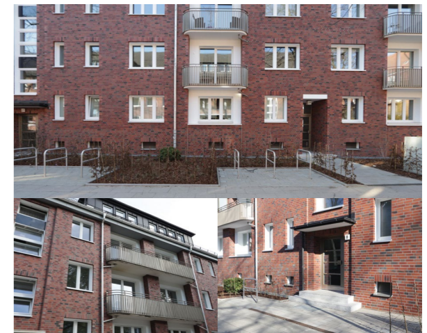
Mit dieser Neuentwicklung bringt die HBH nicht nur modernen Wohnraum, sondern auch soziale und ökologische Innovationen in das Herz von Hamburg-Barmbek-Süd.
