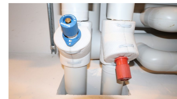
Die HBH modernisiert: Installation neuer hydraulischer Heizkörperventile bei einer Gesamtmodernisierungsmaßnahme
