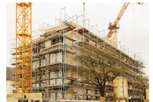
Seit 2023 entsteht in der Sentastraße ein Gebäude, das den energetischen Standard eines Effizienzhauses 40EE erfüllen wird.
